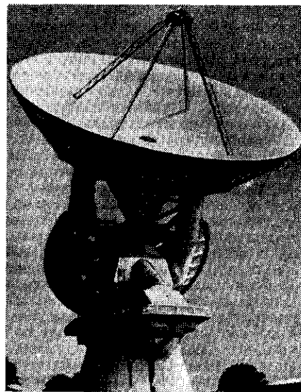
Рис. 1. RT-43 — наиболее крупный радиотелескоп с экваториальной подвеской 43-м параболического зеркала. США, Национальная радиоастрономическая обсерватория, Грин-Бэнк.
